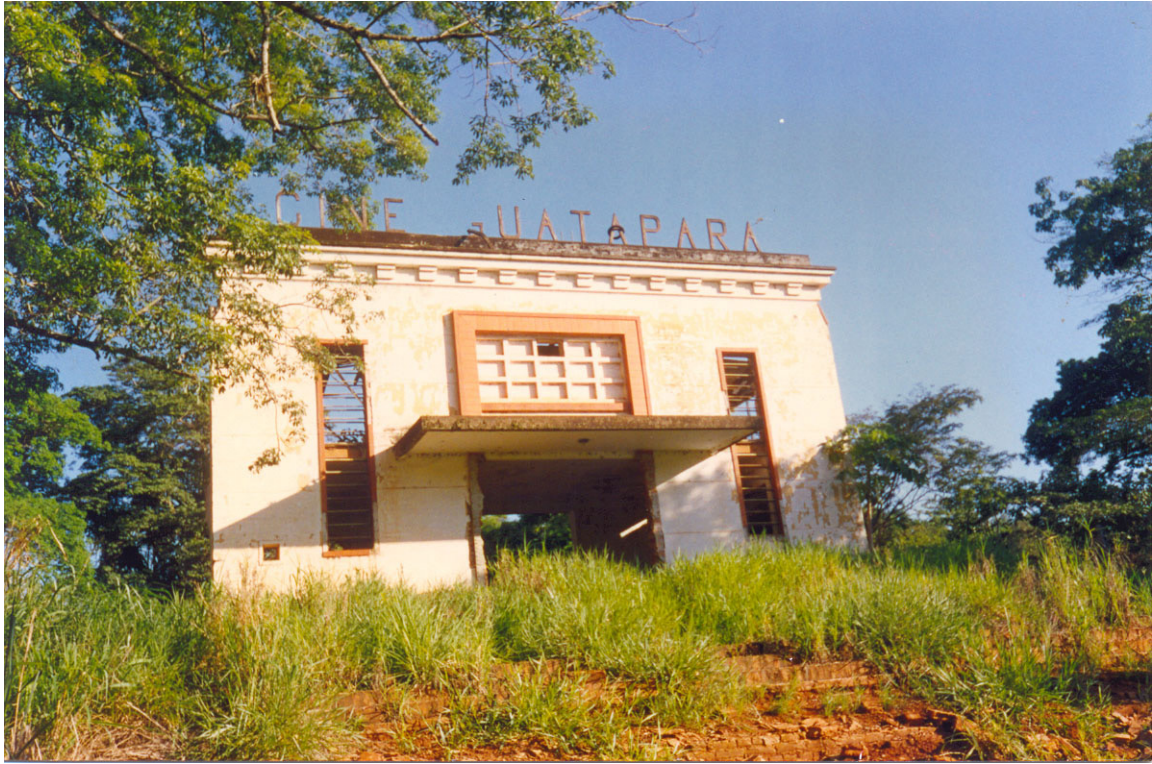
解体され前側だけが存在する映画館（Cine Guatapara´）1998年頃
